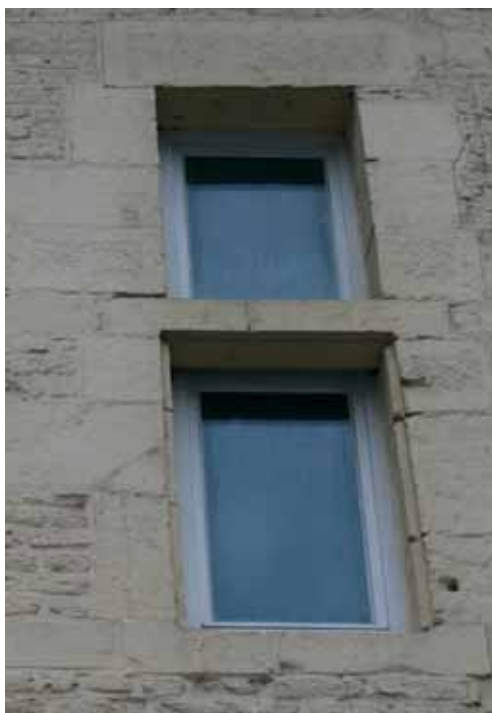
Kloostervenster in de koergevel van de zuidvleugel (tweede venster van links). De aanwezigheid van de tussenregel, de kloosterspouwingen en duimhengselgaten, wijzen erop dat dit raam niet werd verwijderd maar enkel werd dichtgemetseld bij de verbouwing omstreeks 1778.
