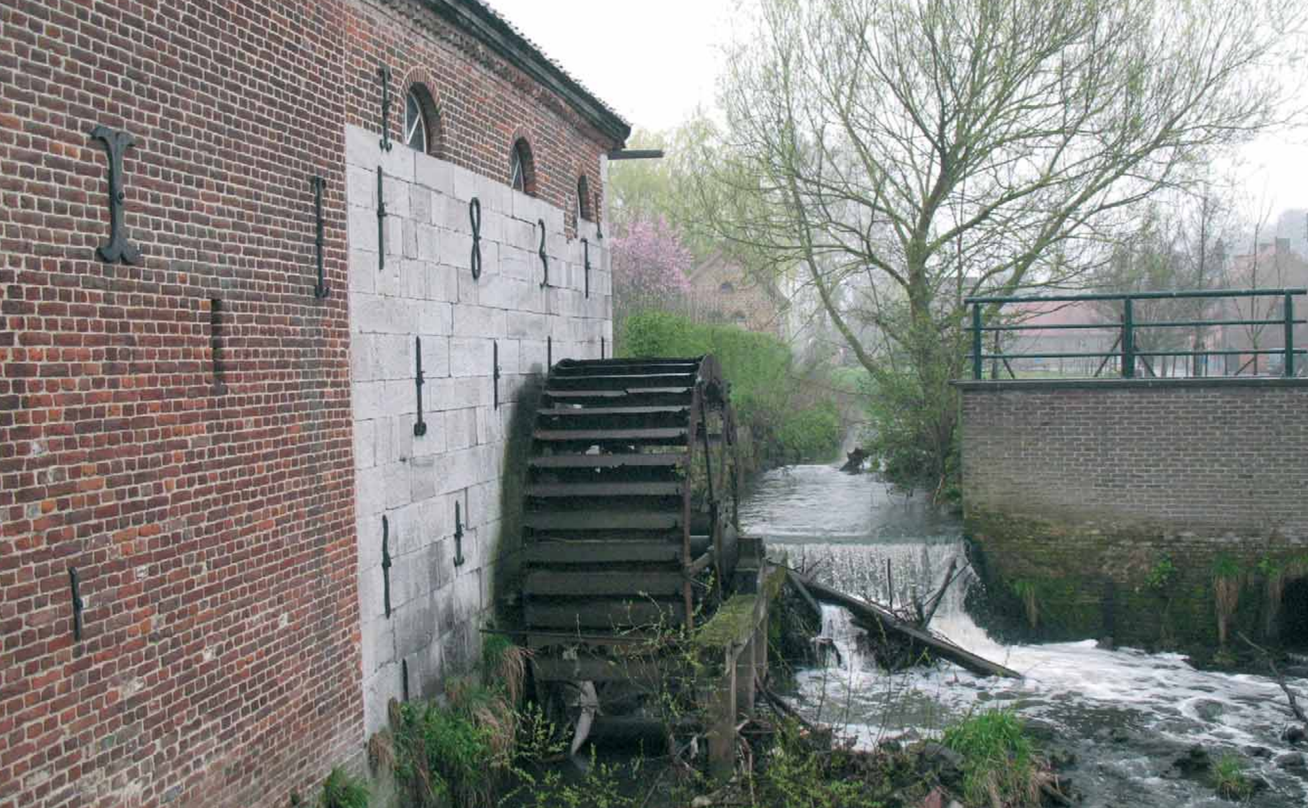
Toestand anno 2010: het ijzerwerk van het waterrad is verroest en de sluis is verdwenen. De molen wacht op een restauratie.
